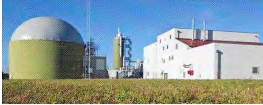
La station a été pensée pour consommer le moins d'énergie possible. Ainsi, sa performance réside dans le fait d'utiliser le potentiel énergétique des boues et des jus de choucroute en les valorisant sous forme de biogaz. Cette énergie dégagée réduit la quantité de matière résiduelle, produit de l'électricité et permet à son tour de sécher la boue et ainsi d'en réduire le volume à évacuer sous forme de granulés secs.
